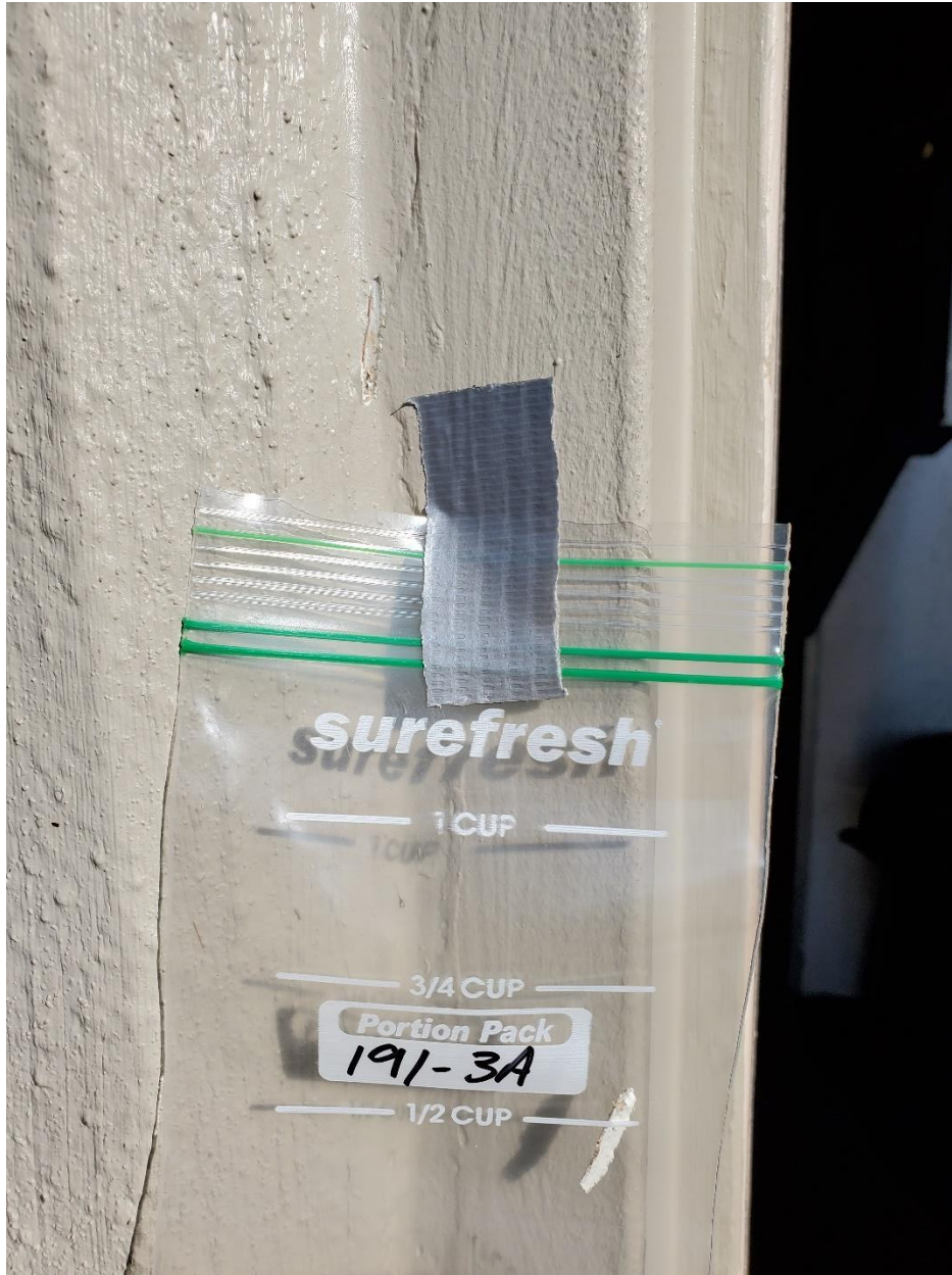
191-3A: Door Caulk [NAD]
